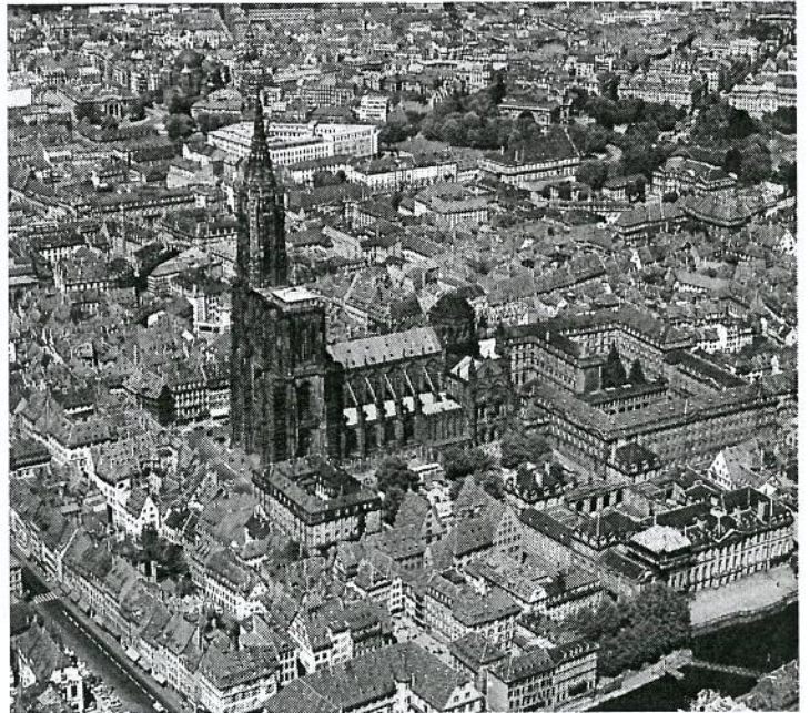
Das Münster in Straßburg mitten in der Altstadt
