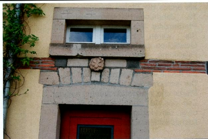
Die römischen Ziegel, die beim Bau der Küsterwohnung mit eingebaut und dann vom Verputz ausgenommen wurden.
