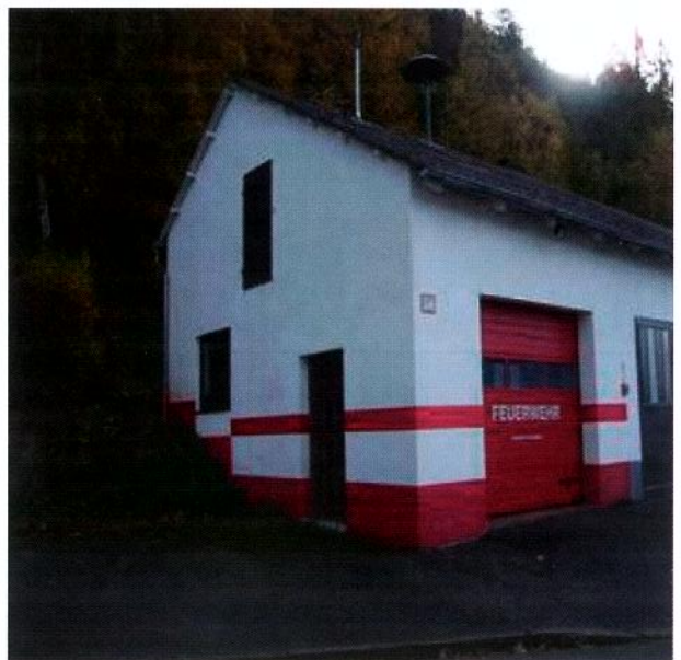
Feuerwehrgerätehaus in Oberbaar
